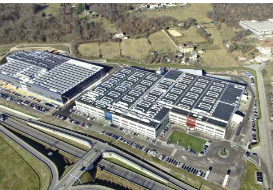
Производственные площадки Fondital Spa в г. Карпенедра ди Вобарно (Брешиа, Италия)
